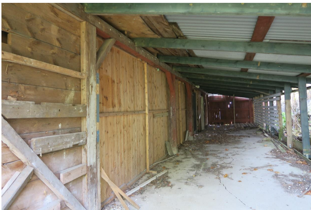
Tillhörande utbyggnad med stolpverkskonstruktion.
