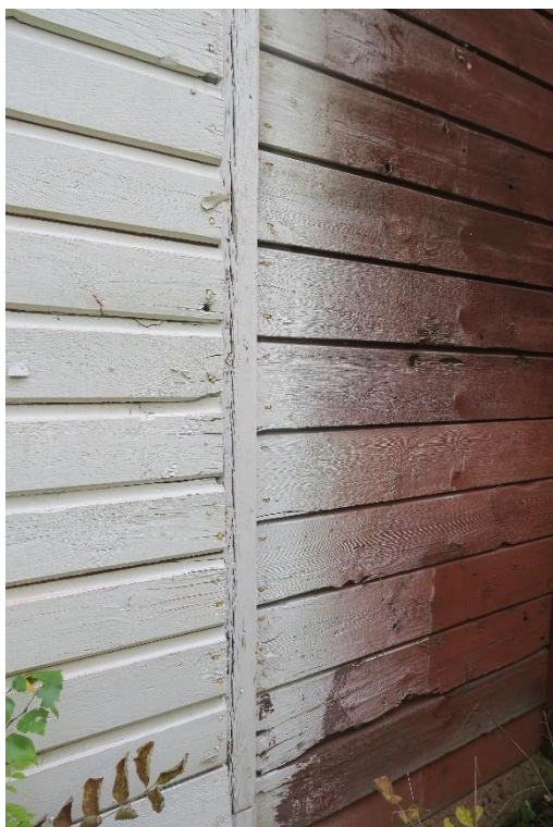
Den vitmålade panelen (till vänster) är nyare än övriga brädor. Spår av spraymålning går tydligt att se.
