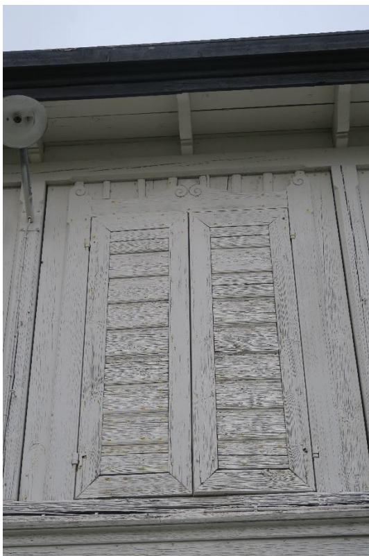
Bild t v. Gavel mot nordöst. Rikligt detaljerat listverk. Bild t h. Gavel mot nordväst. Den fasade spontpanelen på denna del är sekundär och döljer tidigare ingångar från denna sida.
