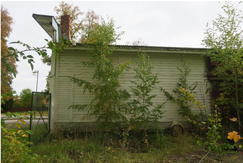
Byggnaden mot gårdssidan i sydväst. Endast den synliga och åtkomliga fasaden har vitmålat 2011. Sekundär spontpanel. Övrig fasad är rödmålad.
