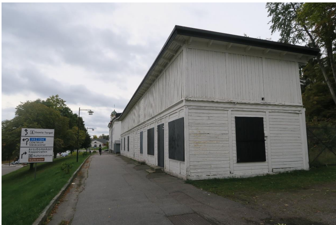
Stenbusgatan mot sydöst. Stora igensatta luckor och ingångar och trösklar vittnar om tidigare verksamheter i byggnaden.
