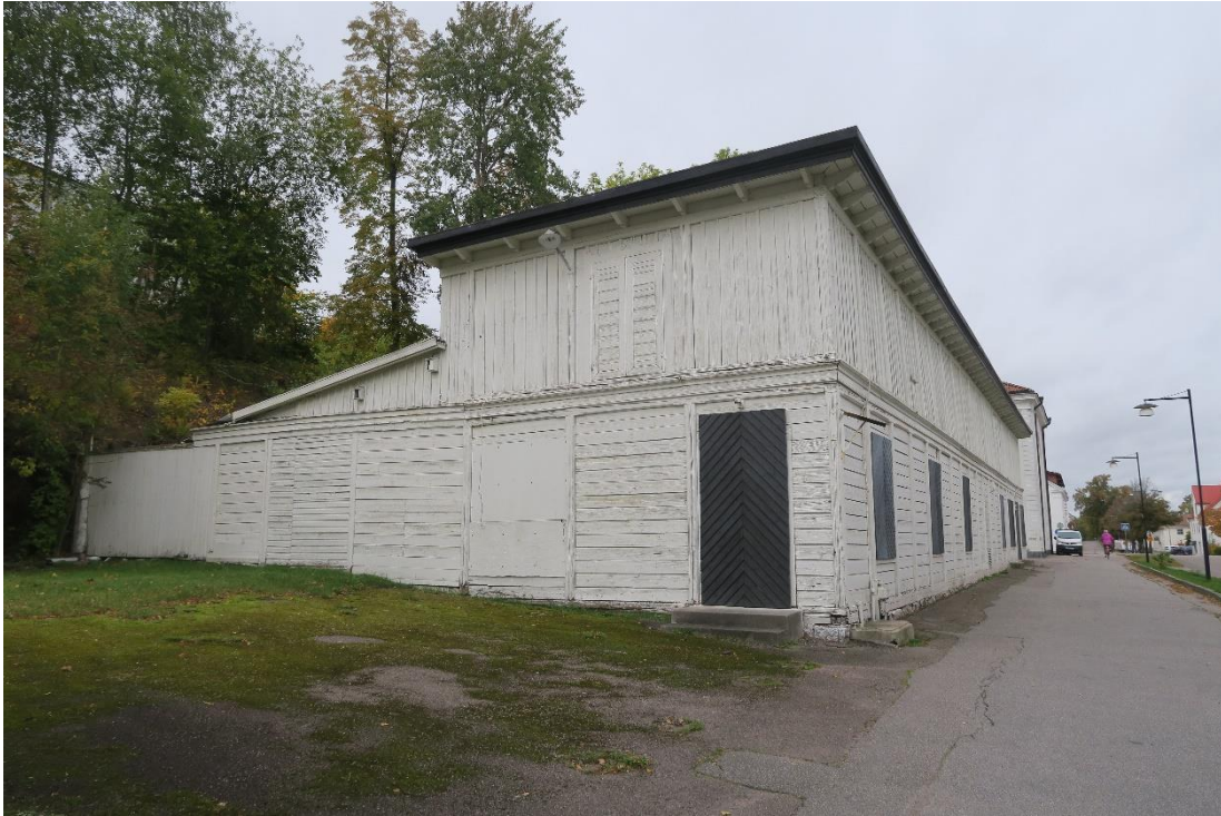
Stenbusgatan mot nordöst. Gavelsidan är ändrad med tillbyggnad med garage. Det utkragande taket kan tydligt avläsas från detta håll.
