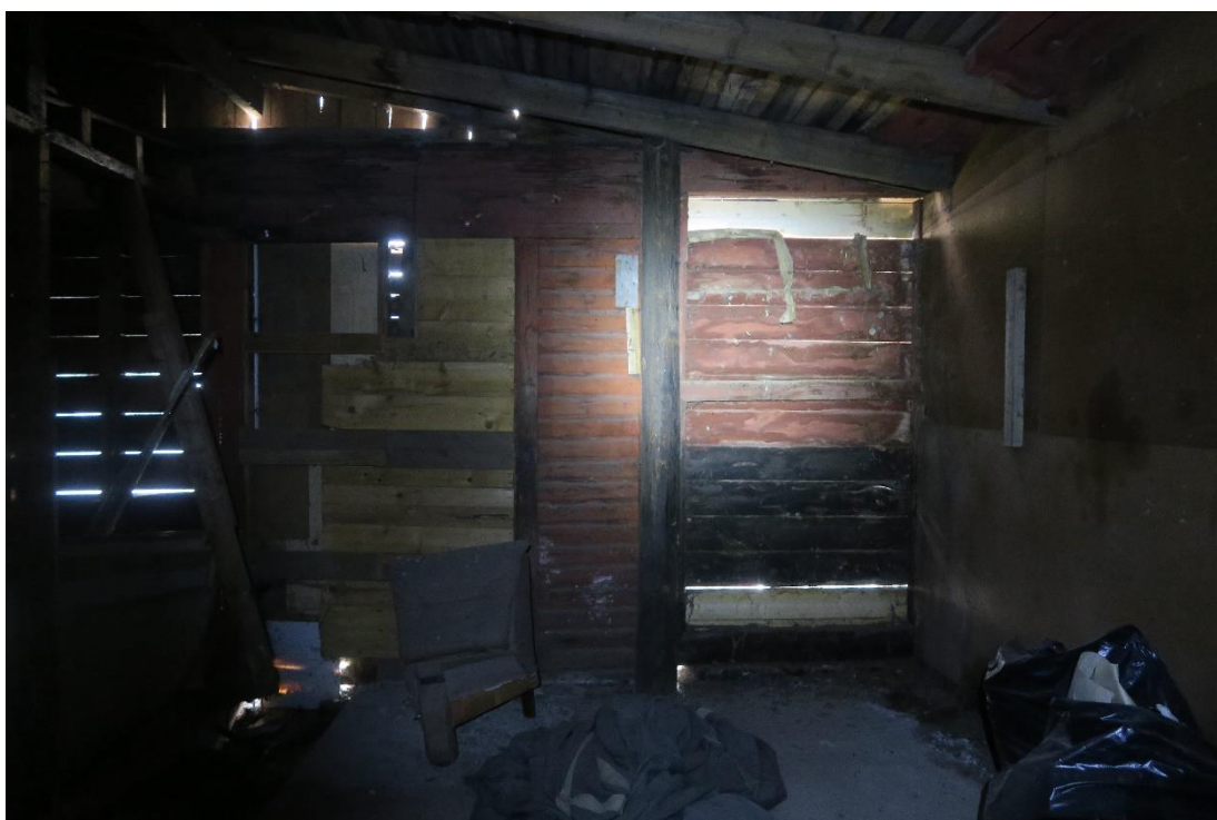
Garagedel med återvunnen panel. Mot söder.
