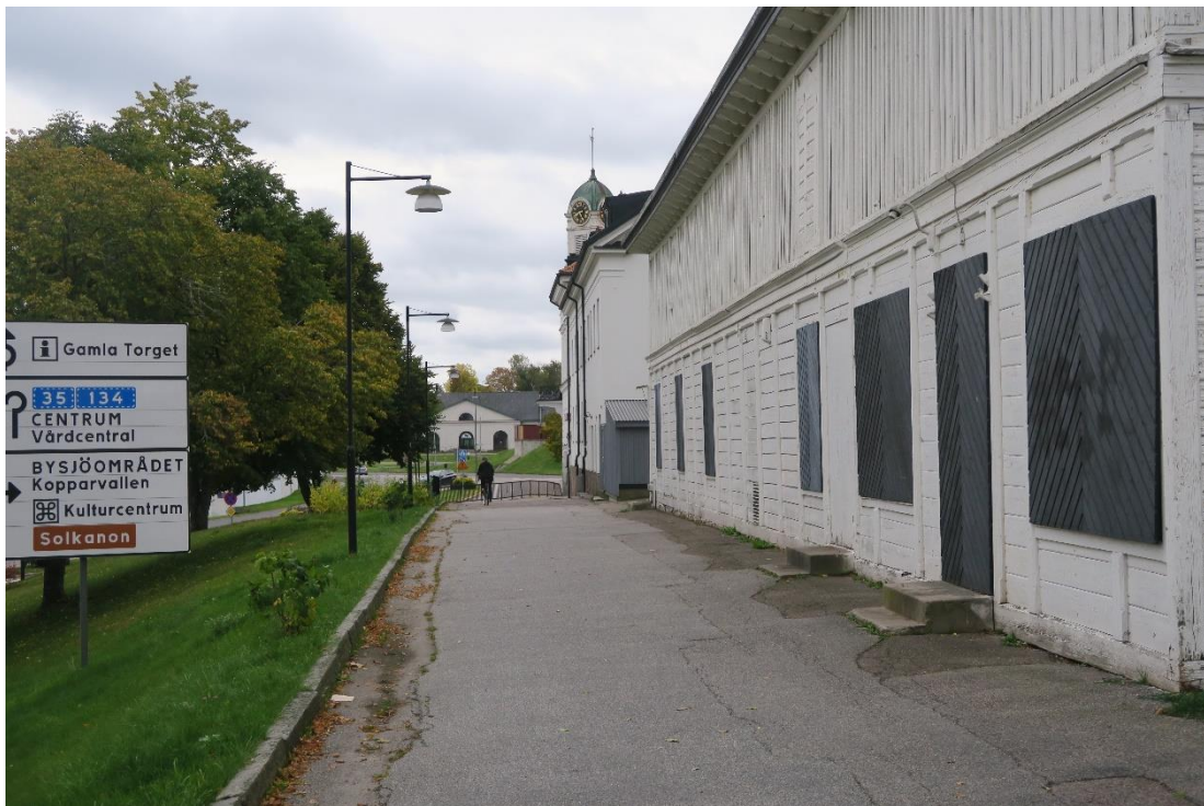
Stenbusgatan mot sydöst. Endast en vindslucka finns kvar ut mot Stenbusgatan. F.d Stallet i bakgrunden. Hotellets klocktorn skimtar bakom takfallen.
