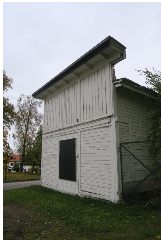
Bild t v. Gavel mot nordöst. Rikligt detaljerat listverk. Bild t h. Gavel mot nordväst. Den fasade spontpanelen på denna del är sekundär och döljer tidigare ingångar från denna sida.
