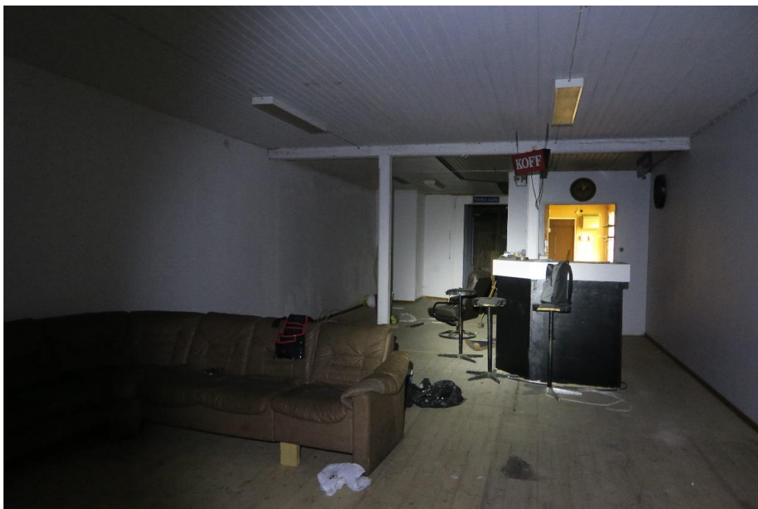
Byggnadens nordvästra del, med synligt stolpverk och takbjälke. Sekundära ytskikt.
