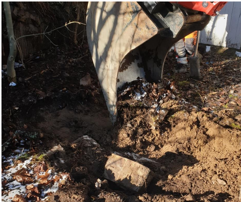
Figur 7 Husgrund av betongblock noterades i punkt 2201.
