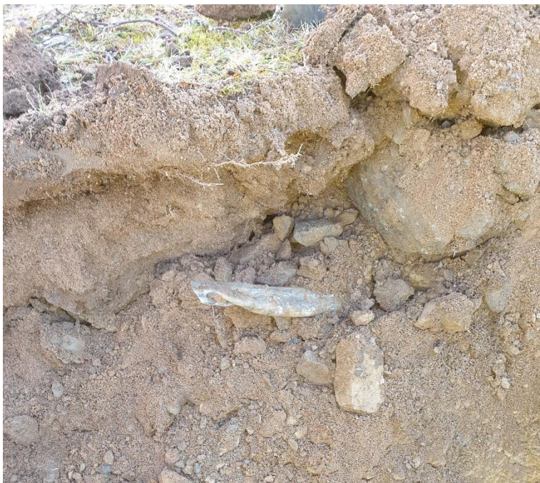
Figur 6 Avklippt äldre kabel ca 0,3 m.u.my.
