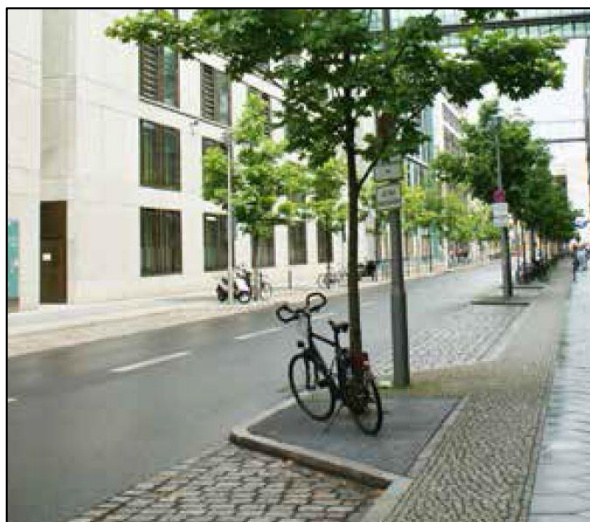
Figur 34. Exempel på träd som planterats i skelettjord och genomsläpplig beläggning på parkeringsyta. (Foto: Uppsala Vatten, 2017)
